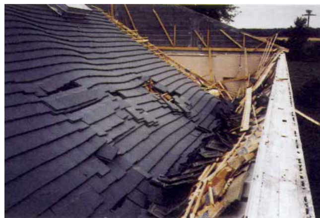
Figure 15 – Effondrement d'une charpente en fermettes sous charges permanentes, deux ans après sa construction
