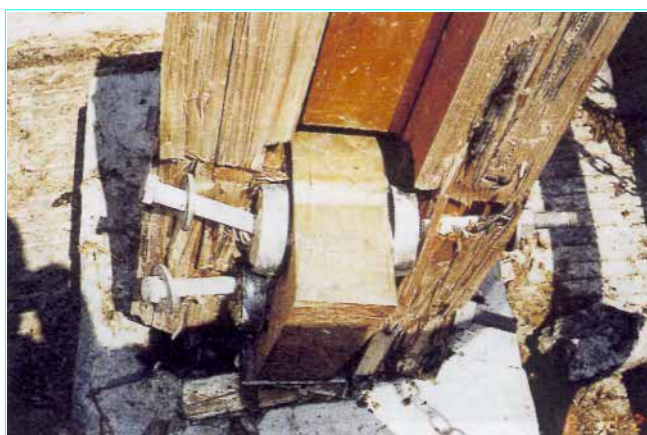
a) rupture de fixation sur ferrure d'ancrage
