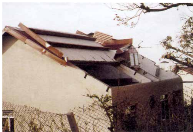
Figure 37 – Rives de toitures arrachées par l'ouragan Hugo (photo F. Issaly)
