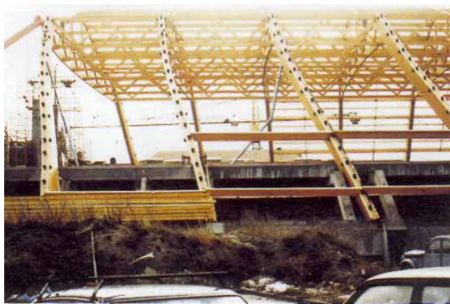
Figure 34 – Flambement en cours de montage
