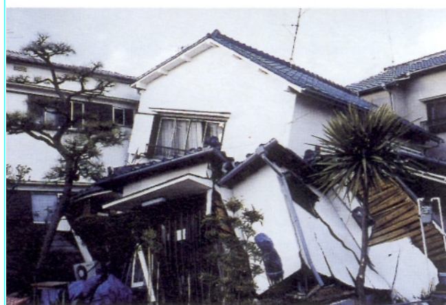
(b) dislocation du rez-de-chaussée d'une maison moderne
