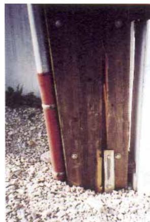
Figure 32 – Fissure en pied de poteau de portique bloqué en rotation
