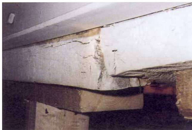
Figure 5 – Rupture différée d'un entrain de ferme
