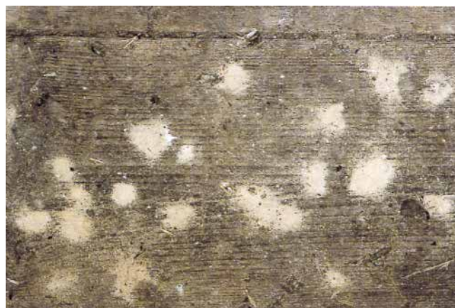
Figure 7 – Plancher ancien en résineux attaqué par des capricornes
