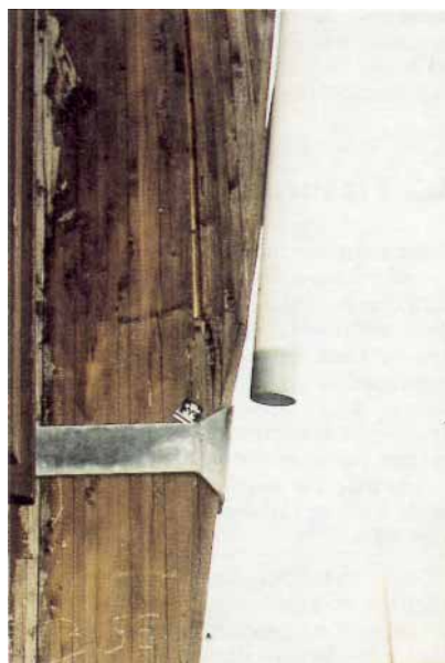
Figure 23 – Pied de poteau avec lamelles tranchées
