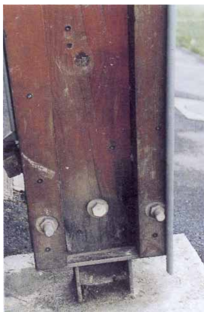
Figure 10 – Pieds de poteaux extérieurs traités par injection de bore et protégés
