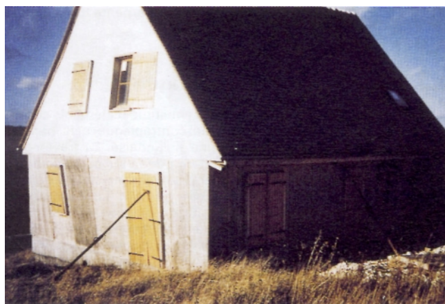
Figure 19 – Instabilité des murs d'une maison à ossature bois
