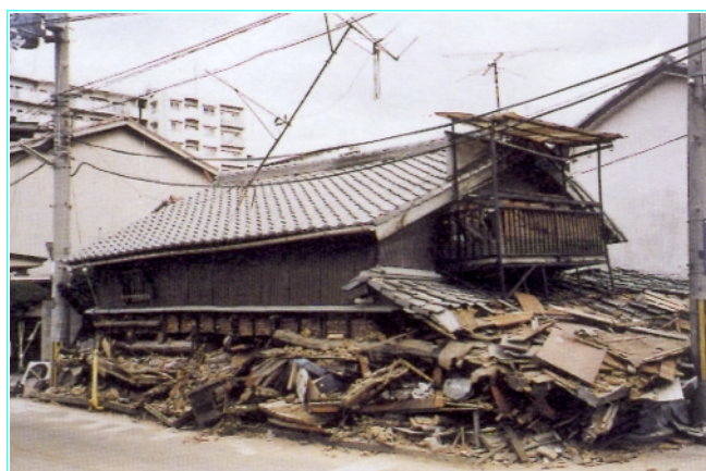
(a) effondrement du rez-de-chaussée d'une maison traditionnelle
