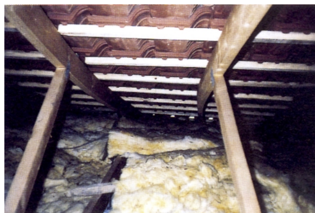
Figure 13 – Glissement et arrachement des pointes aux joints de liteaux
