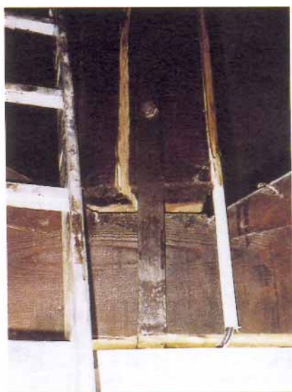
(a) erreur de conception de l'assemblage des diagonales centrales d'une ferme latine
