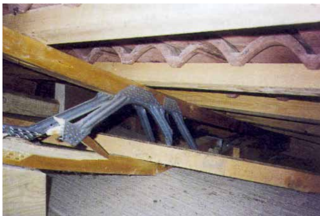
Figure 17 – Rupture de poutrelle à membrures bois
