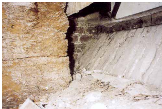
Figure 8 – Poutre très ancienne superficiellement dégradée par le lyctus
