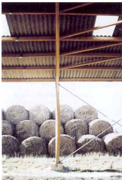
Figure 18 – Déversement de portique en LVL ( Laminated Veneer Lumber )
