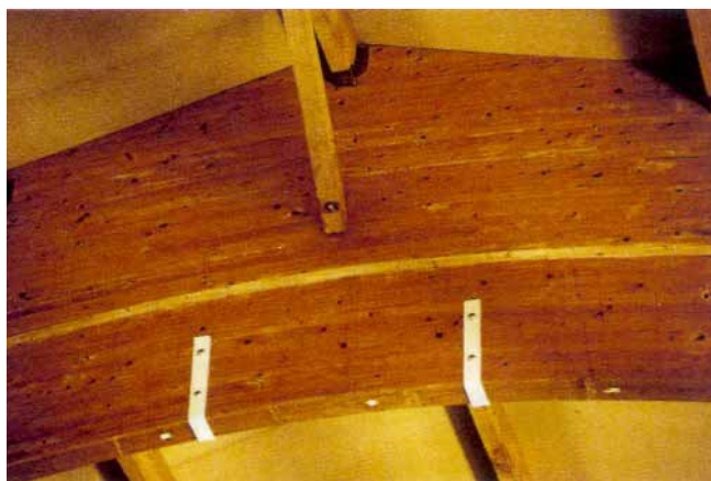
Figure 22 – Réparation de poutre courbe fissurée
