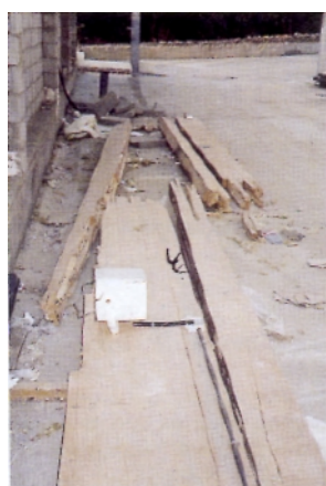
(a) effondrement de poutre à la suite d'une pluie d'orage
