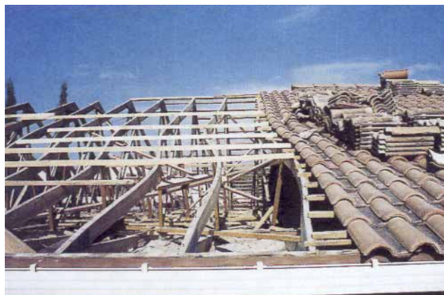
Figure 11 – Flambement réel de fermettes
