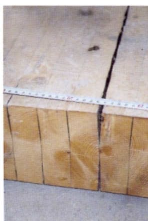
(b) défaut de collage ; poutre identique à celle de la figure 26a
