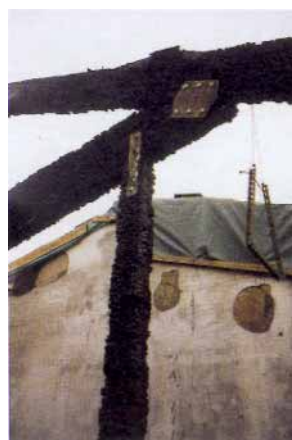
Figure 38 – Charpente en lamellé-collé après un incendie
