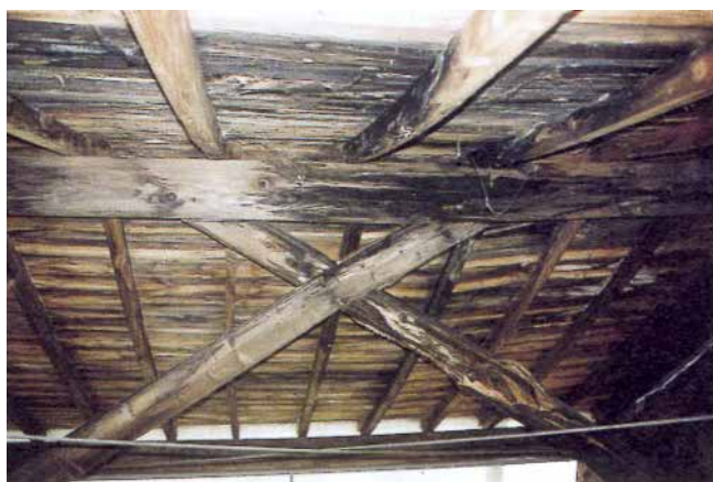
Figure 9 – Pannes et croix de contreventement en phase finale de dégradation par la mérule
