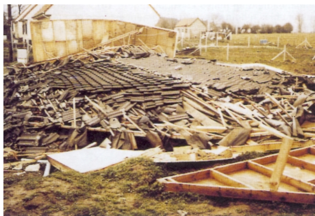
Figure 20 – Effondrement d'une maison à ossature bois
